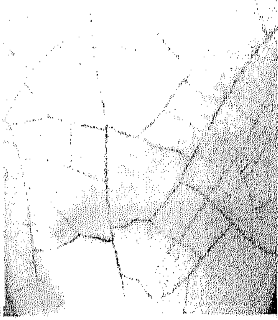
شكل (١٨) يوضح عيب التشقق
